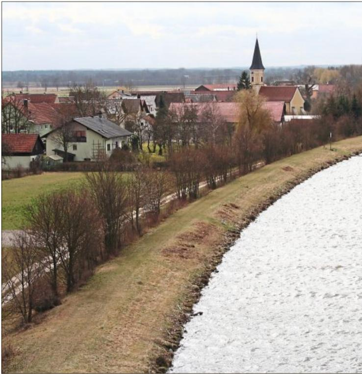
Die Donau bei Kiefenholz liegt mehrere Meter über dem Bodenniveau des Ortes. Würde nicht laufend das durch den Damm gepresste Grundwasser zurück in die Staustufe gepumpt, wären etliche Ortschaften in der Gegend wohl längst untergegangen.
